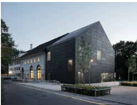
Kantonsschule Wettingen, Einbau Mensa, Wettingen, 2007/08
