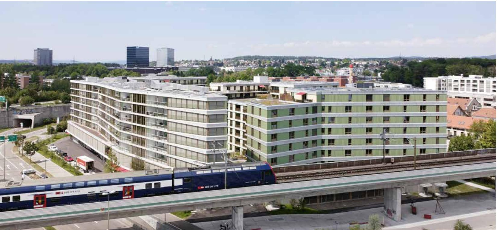
cher und wohnlicher. Die Geschossbänder verjüngen sich zugunsten raumhoher Fenster. An die Stelle der hinterlüfteten Bekleidung aus Faserzementplatten tritt eine Kompaktfassade mit vertikalem Besenstrichputz in blassem Grün und Gelb. Hinter braunen Staketengeländern reihen sich Balkonmöbel und Topfpflanzen auf.
