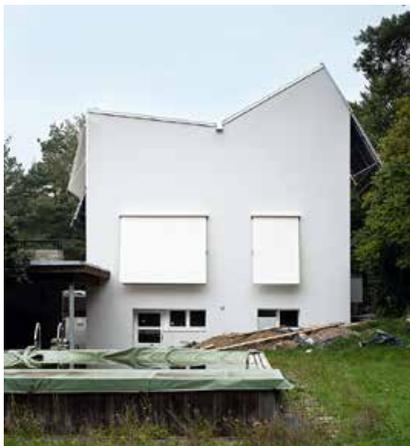
Beim Einfamilienhaus in Bassersdorf wurden gemauerte Aussenwände mit einem leichten Holzelementdach und Vordächern aus Faserzementplatten kombiniert.
