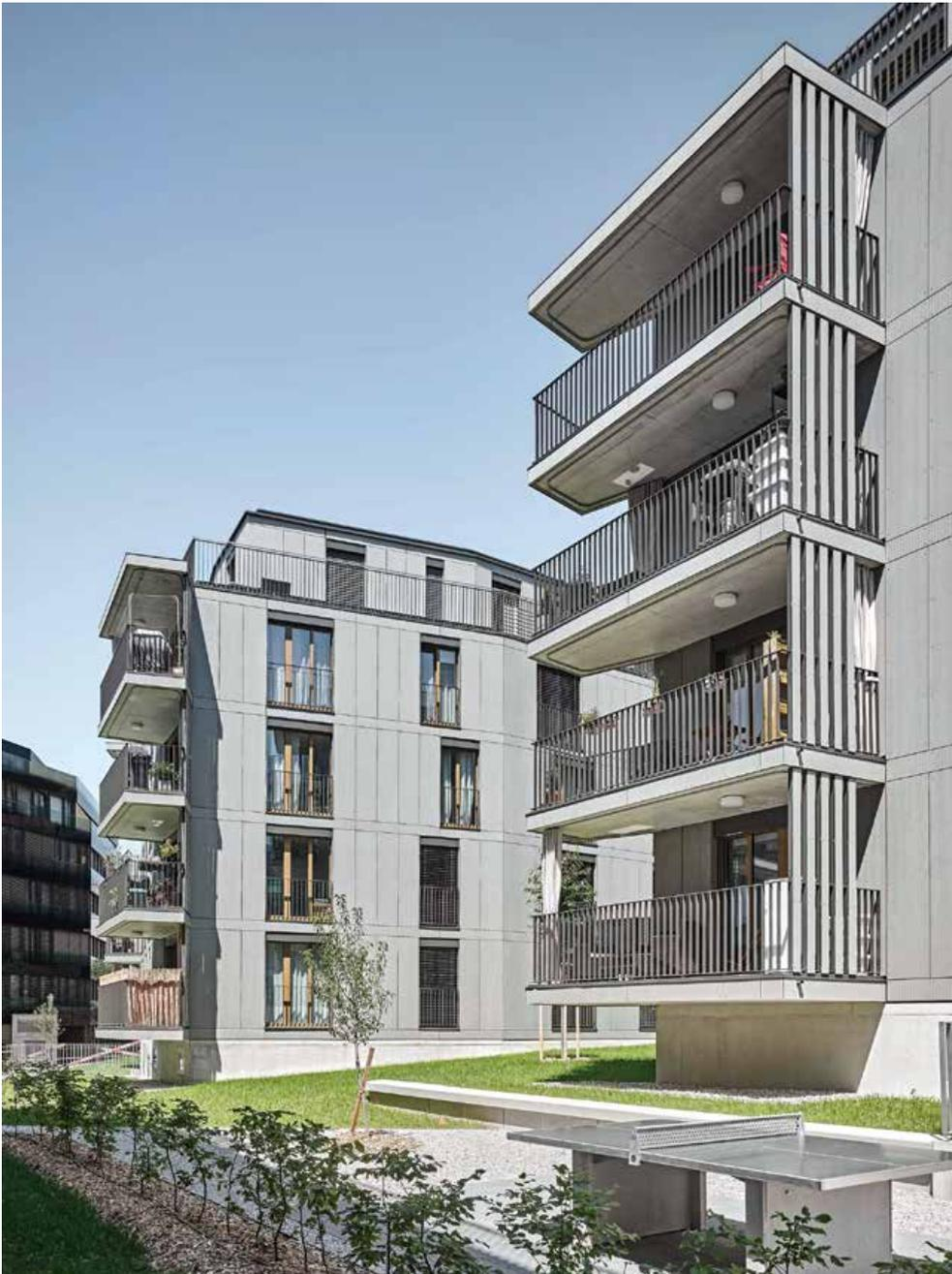
Der Grundriss wurde auf die Abmessung der Fassadenplatten abgestimmt, um einen Verschnitt zu vermeiden.
