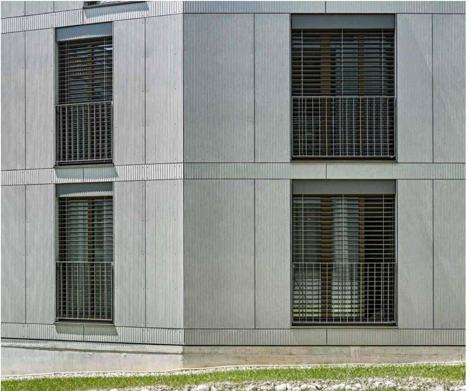
In diese Faserzementplatten wurden zwei Millimeter tiefe Rillen geätzt. Das erzeugt eine sehr feine Textur wie bei einem Nadelstreifenanzug.
