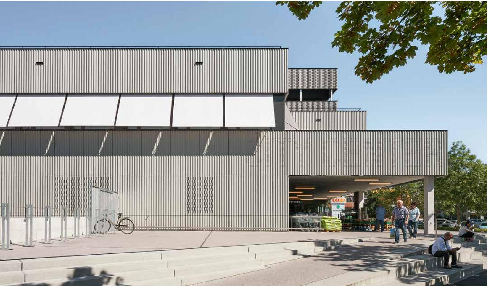
Das Einkaufszentrum wurde saniert und um drei Geschosse aufgestockt. Die neue Hülle, eine Mischung aus perforierten und geschlossenen Faserzementplatten, spielt mit dem ursprünglichen grauen Erscheinungsbild.
